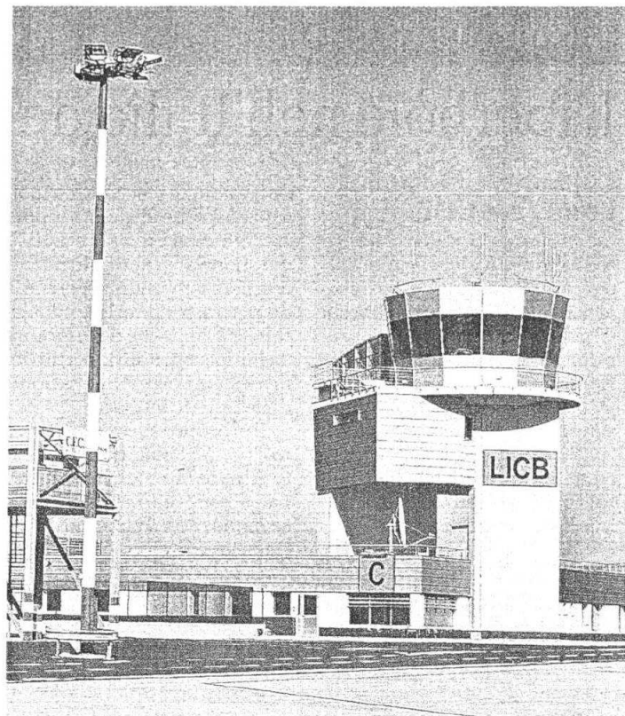
La torre di controllo dell'aeroporto di Comiso
